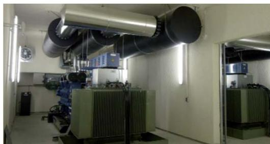
Un groupe électrogène est constitué d'un alternateur couplé à un moteur thermique (souvent diesel) lui fournissant de l'énergie mécanique. Un moteur diesel fourni, en moyenne, 0,42 J d'énergie mécanique pour 1 J d'énergie chimique (venant du diesel) consommée.
